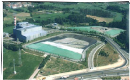
O Confinamento Técnico surge para dar o destino adequado aos resíduos que não podem ser valorizados nas restantes infra-estruturas (Centro de Triagem, Central de Valorização Orgânica e Central de Valorização Energética).
